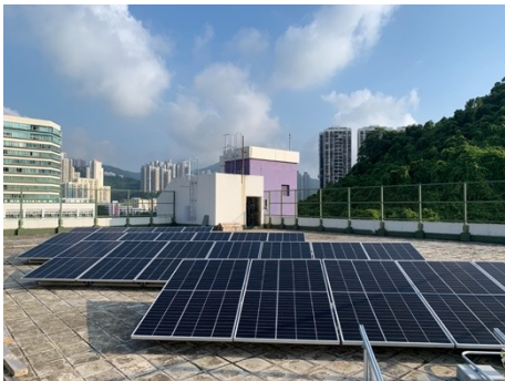
天台安裝太陽能板
